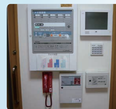
自動火災通報装置
